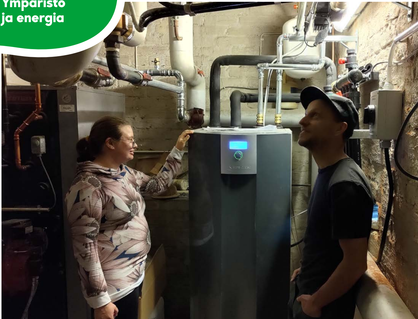
Kristiina Ojala ja Aapo Korkeaaja esittelevät tyytyväisenä Korkeaajan kylätalolle asennettua maalämpöjärjestelmää.
